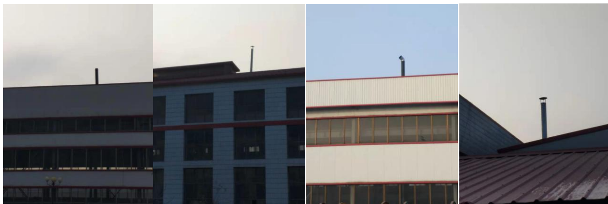
图 24 三车间、四车间、原材料车间排气筒分布（P2-P5）
