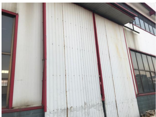
图 20 车间密闭（四车间）
