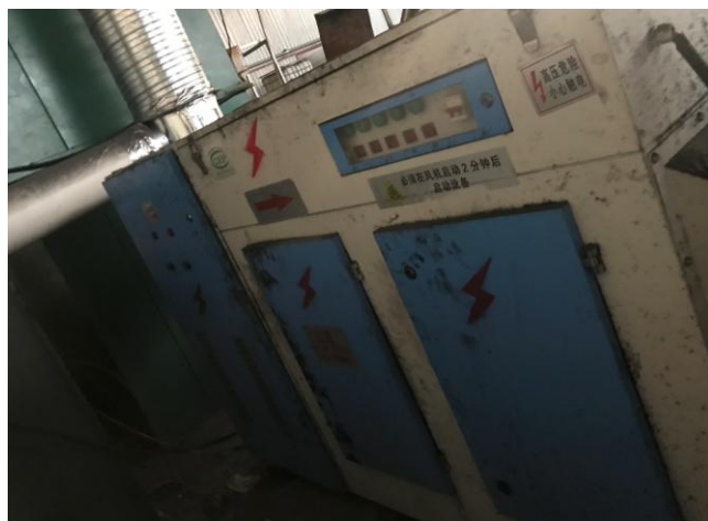
图 9 原料车间等离子 UV 光氧净化器
