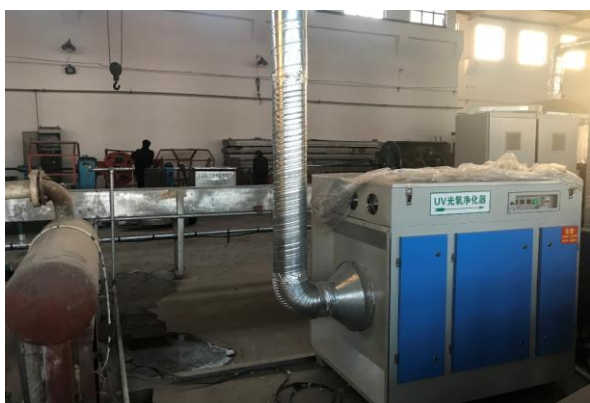
图 16 等离子 UV 光氧净化器（三车间东）
